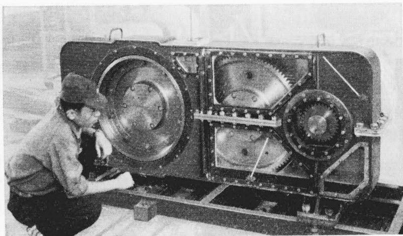
第7図 駆 動 装 置 試 験 機
