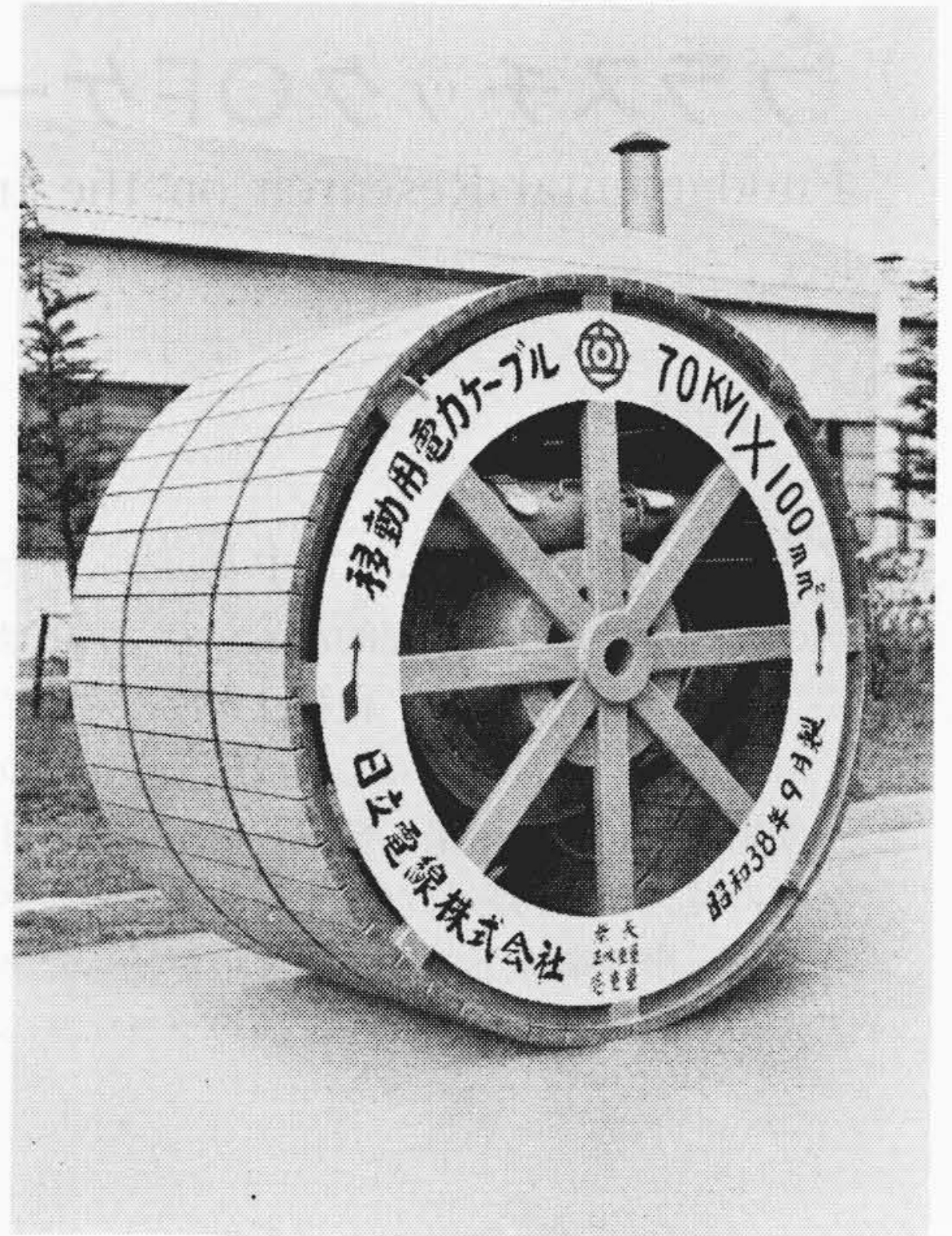
第 12 図 70 kV 単心 100 mm 2 架橋ポリエチレン 移動用ケーブル巻付け出荷状況
