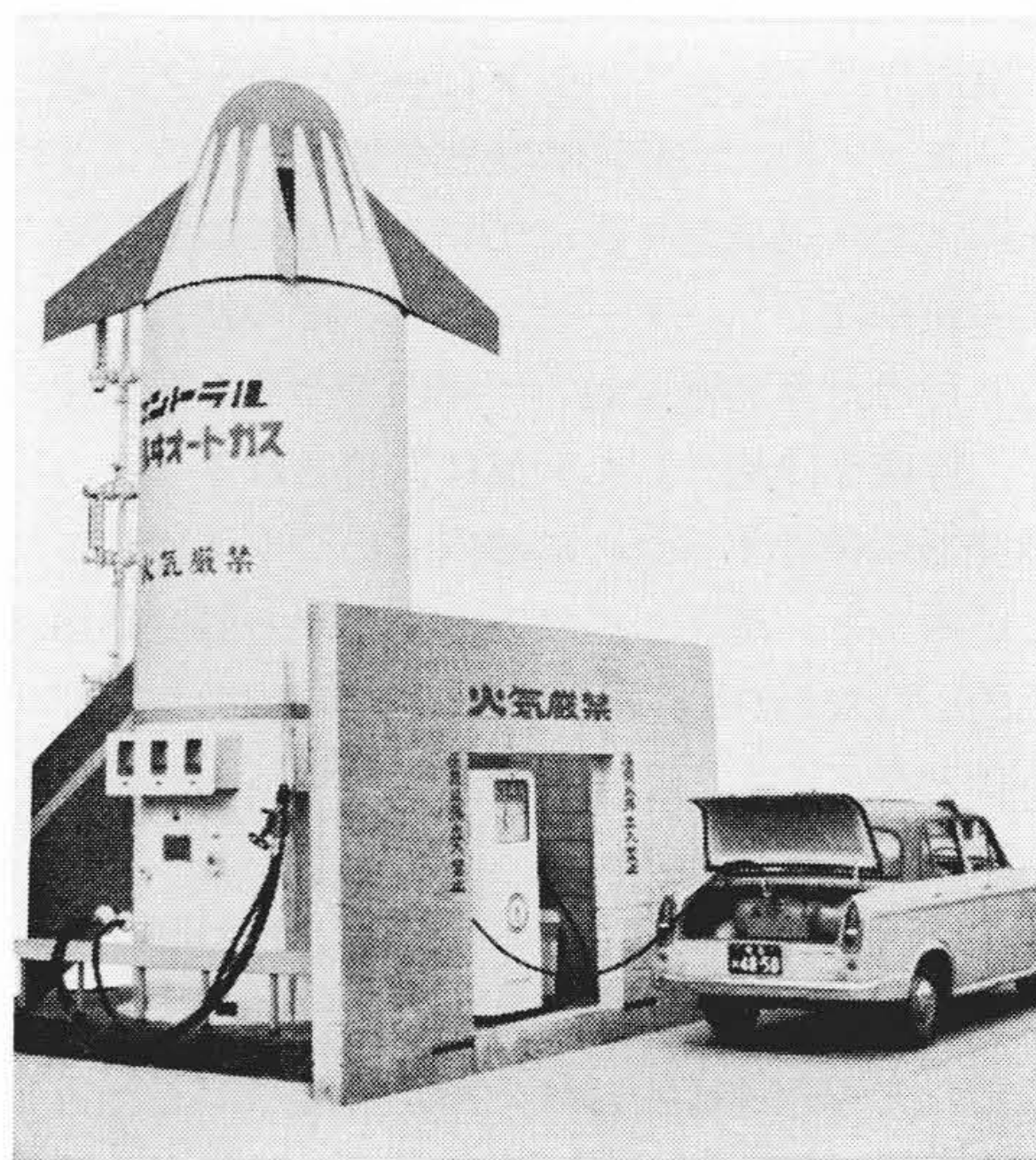
第 24 図 LP ガススタンド (セントラル石油株式会社川崎共同タクシー給油所)
