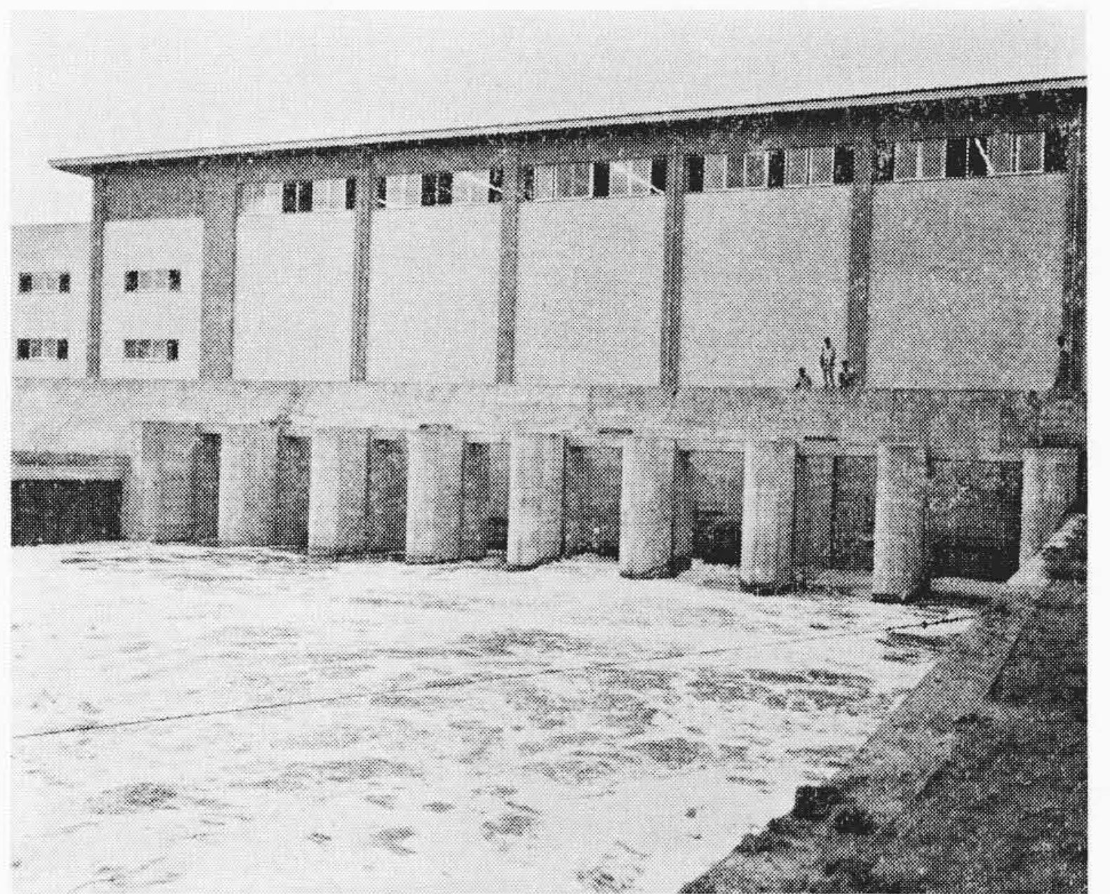
第 1 図 排水ポンプ場
