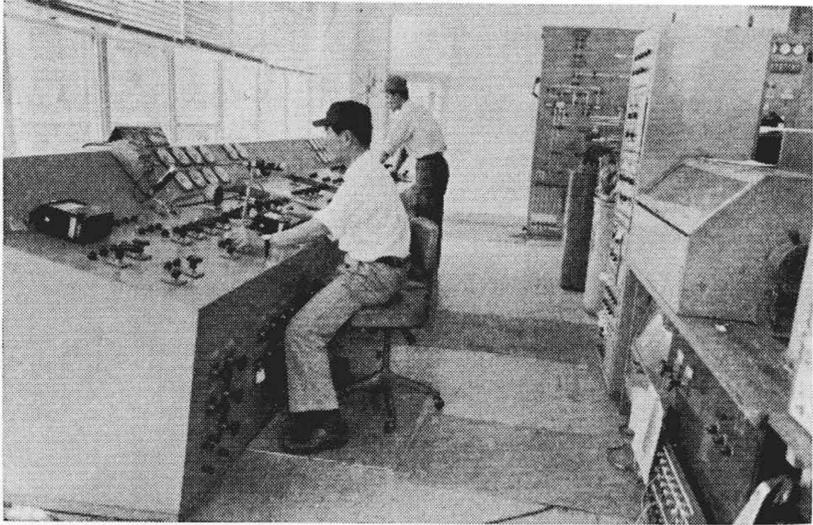
第17図(a) 短絡試験操作盤
