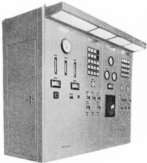
第32図 関西電力株式会社堺港発電所発電機固定子冷却制御盤
