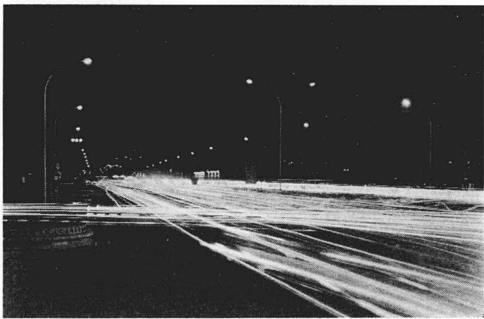
第14図 第2阪神国道照明施設
