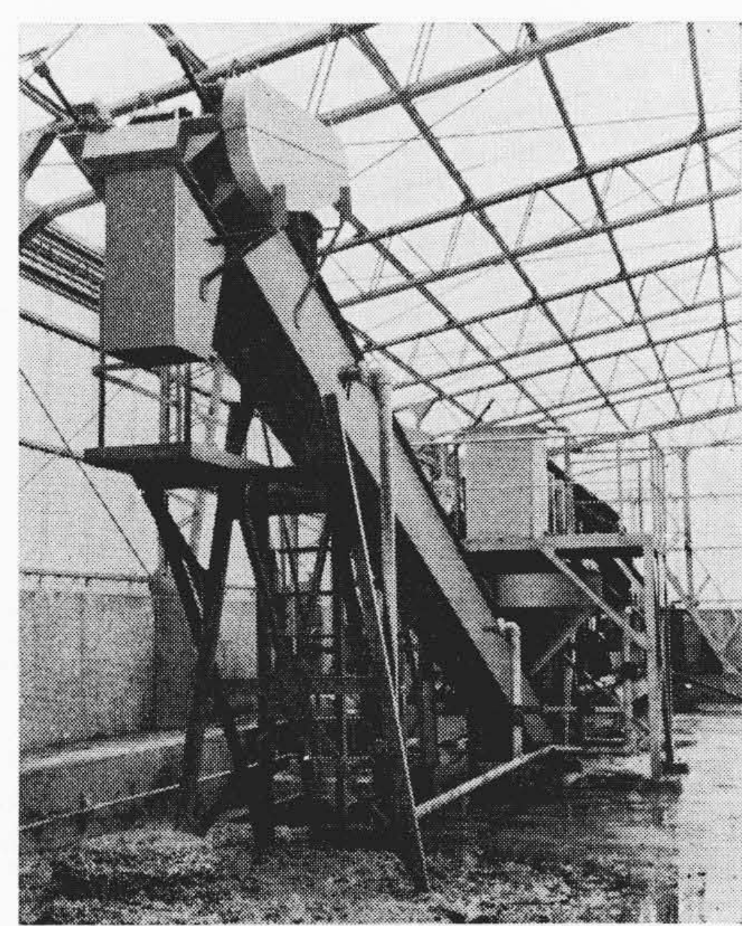
第 32 図 東京都芝浦処理場洗砂装置
