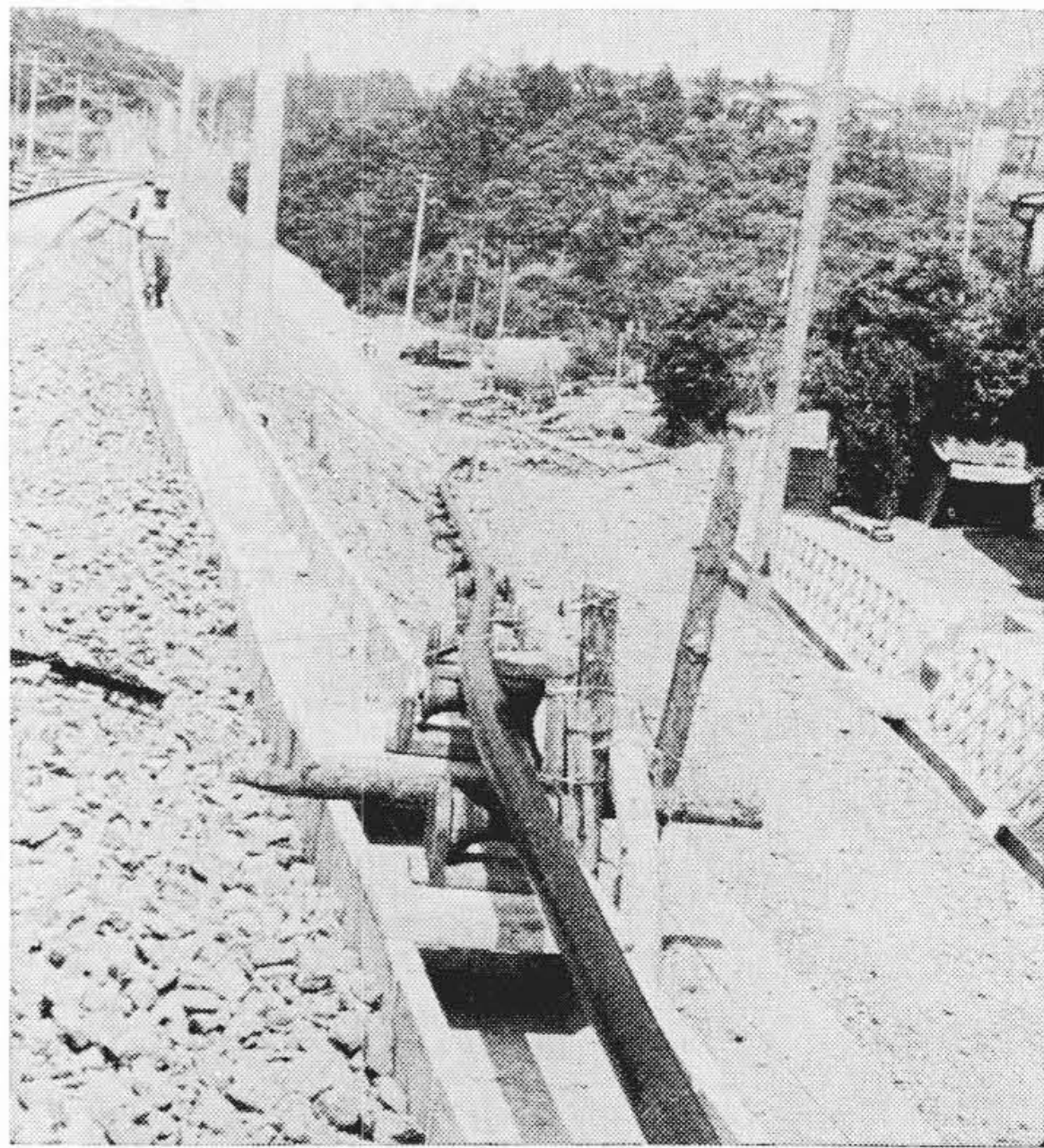
第4図 アルミ被OFケーブルの布設状況
