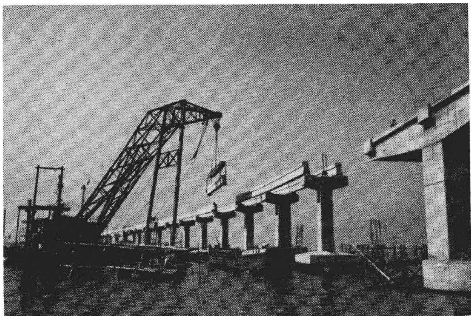
第21図 フローティングクレーンによる架設
