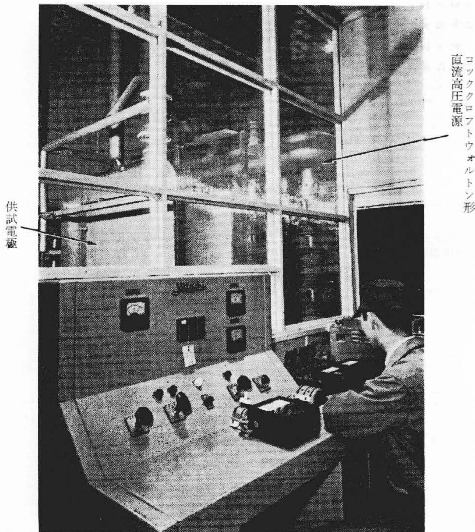
第4図 直流高電圧電源制御および放電特性測定室
