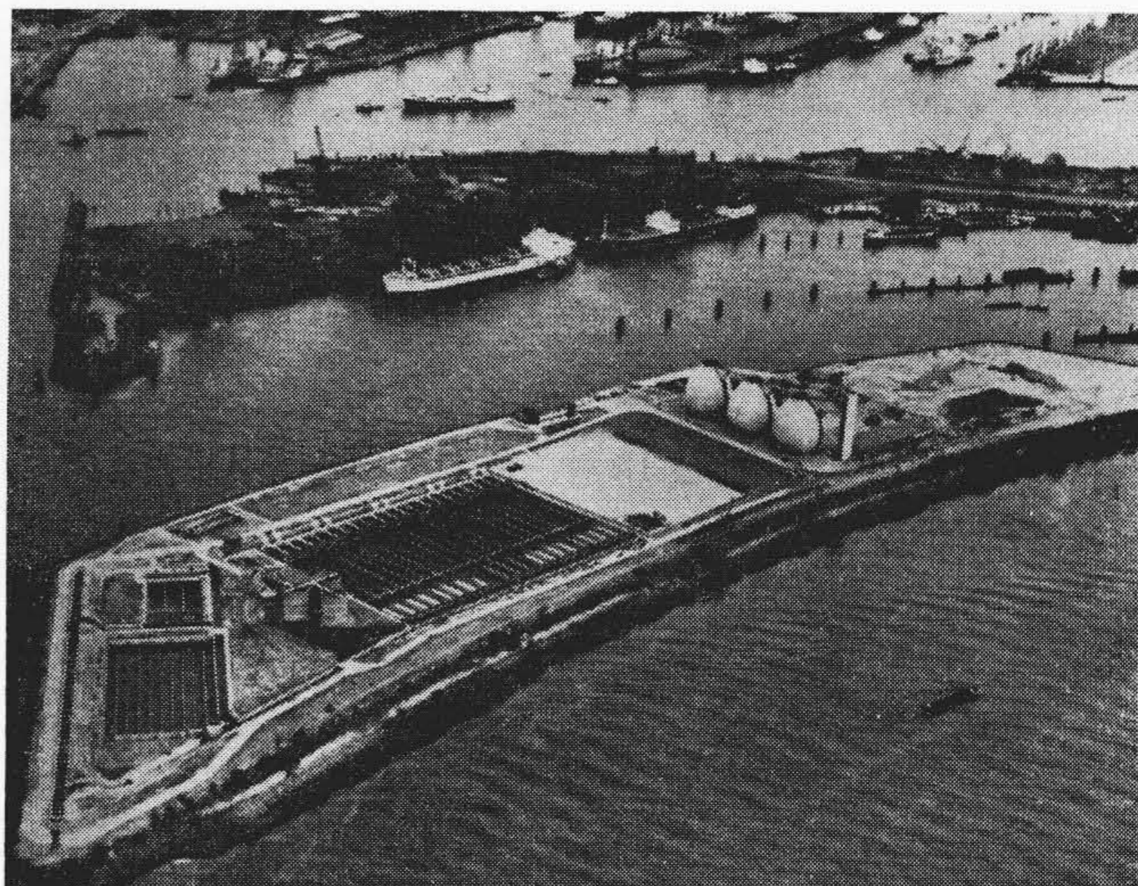
第12図 ハンブルグ：ケールプラントヘフト下水本処理場の全景
