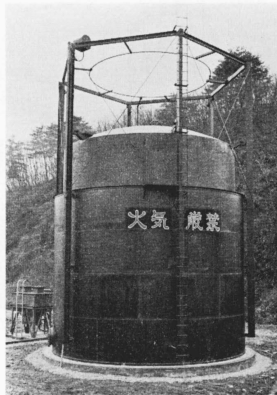
第20図 ガスタンクと乾式脱硫器
