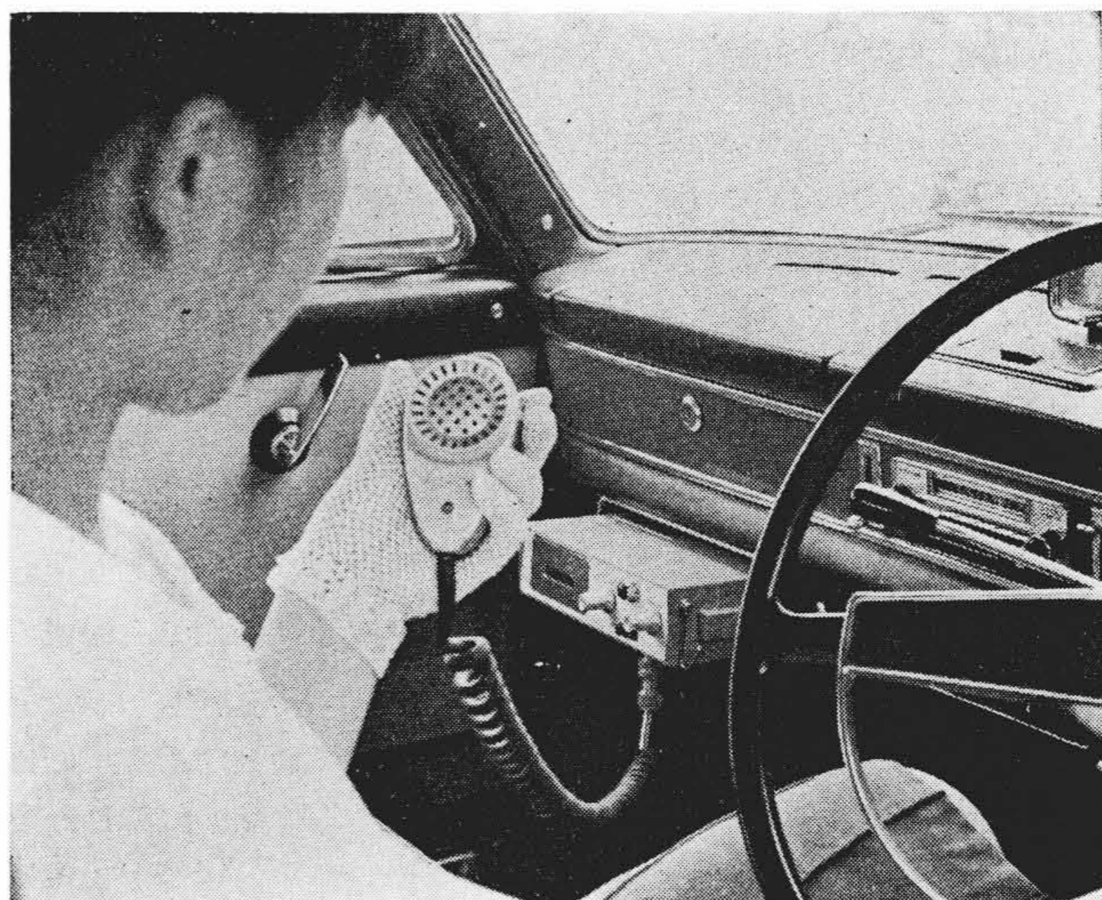
第1図 小形自動車に積載した SEM-1021A 形(10 W)無線機
