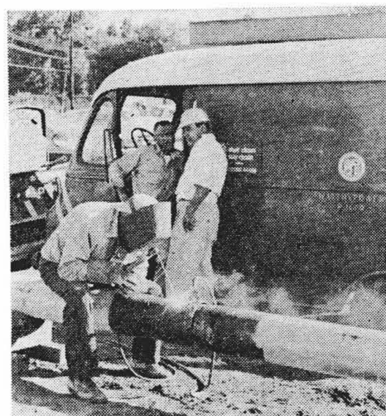
図13 鋼管の溶接
