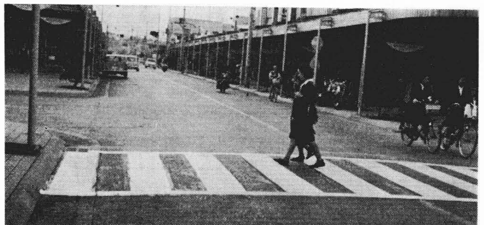
図1 横断歩道施工例(前橋市内)
