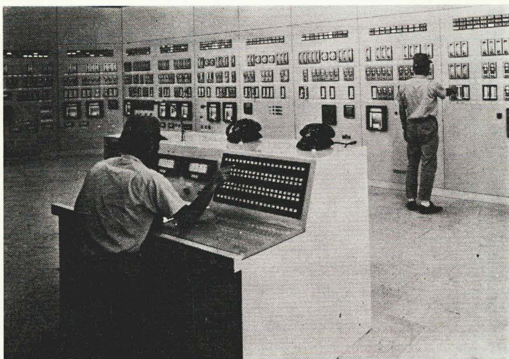
図5 ユニトリール電子式、空気式シリーズを混在させた計装パネル
