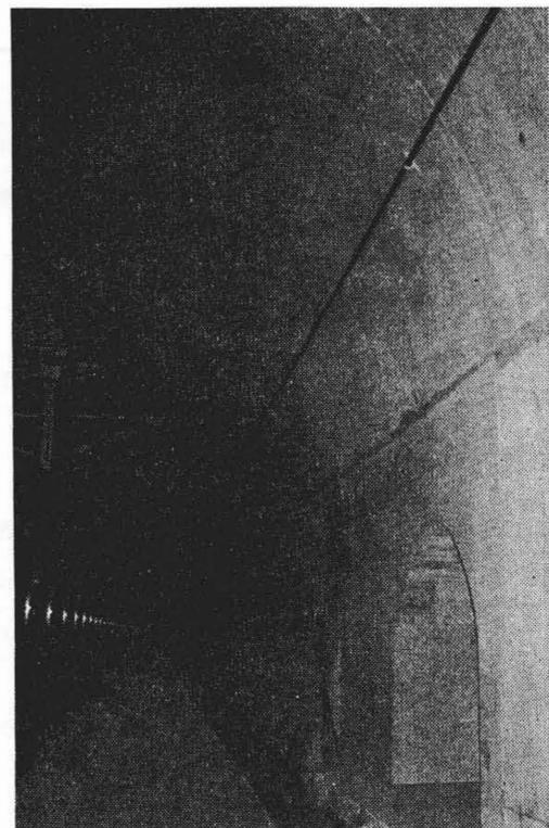
図3 トンネル内に架設された漏えい同軸ケーブル
