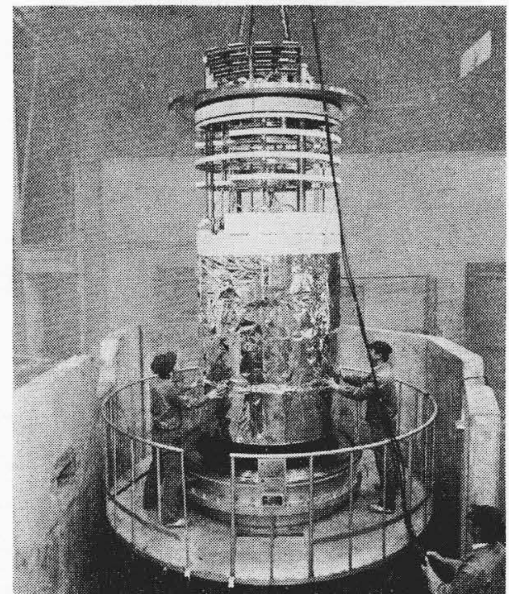
図9 組立中の超電導マグネット
