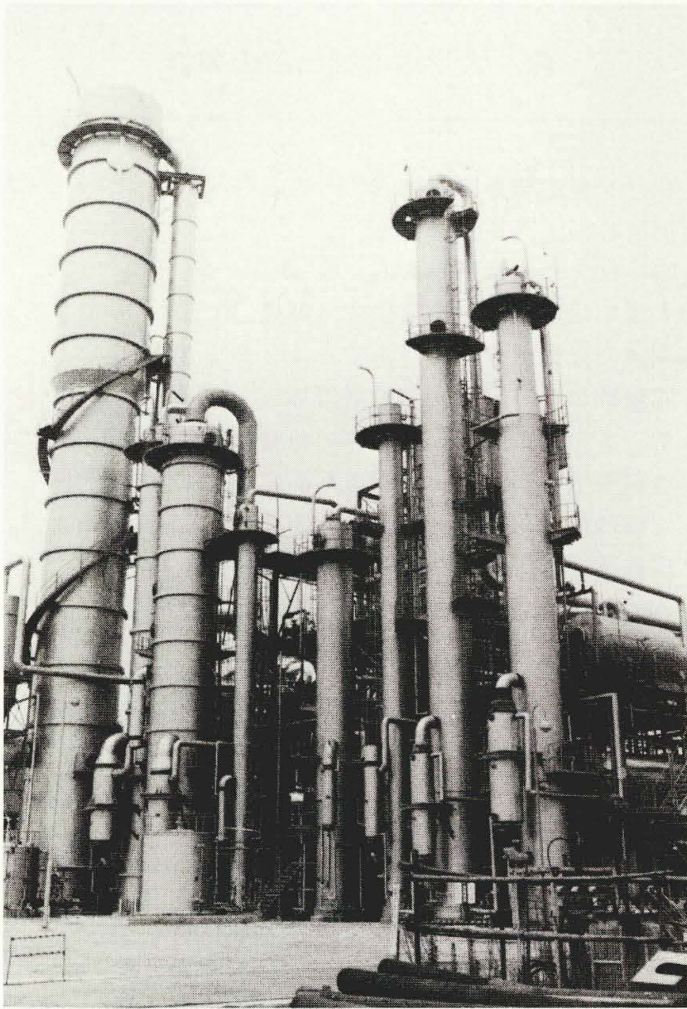
図4 スチレンモノマー製造プラント
