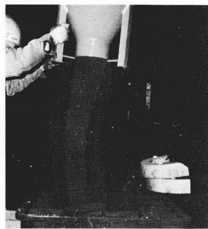
図11 乾式流動N砂の注入状況
