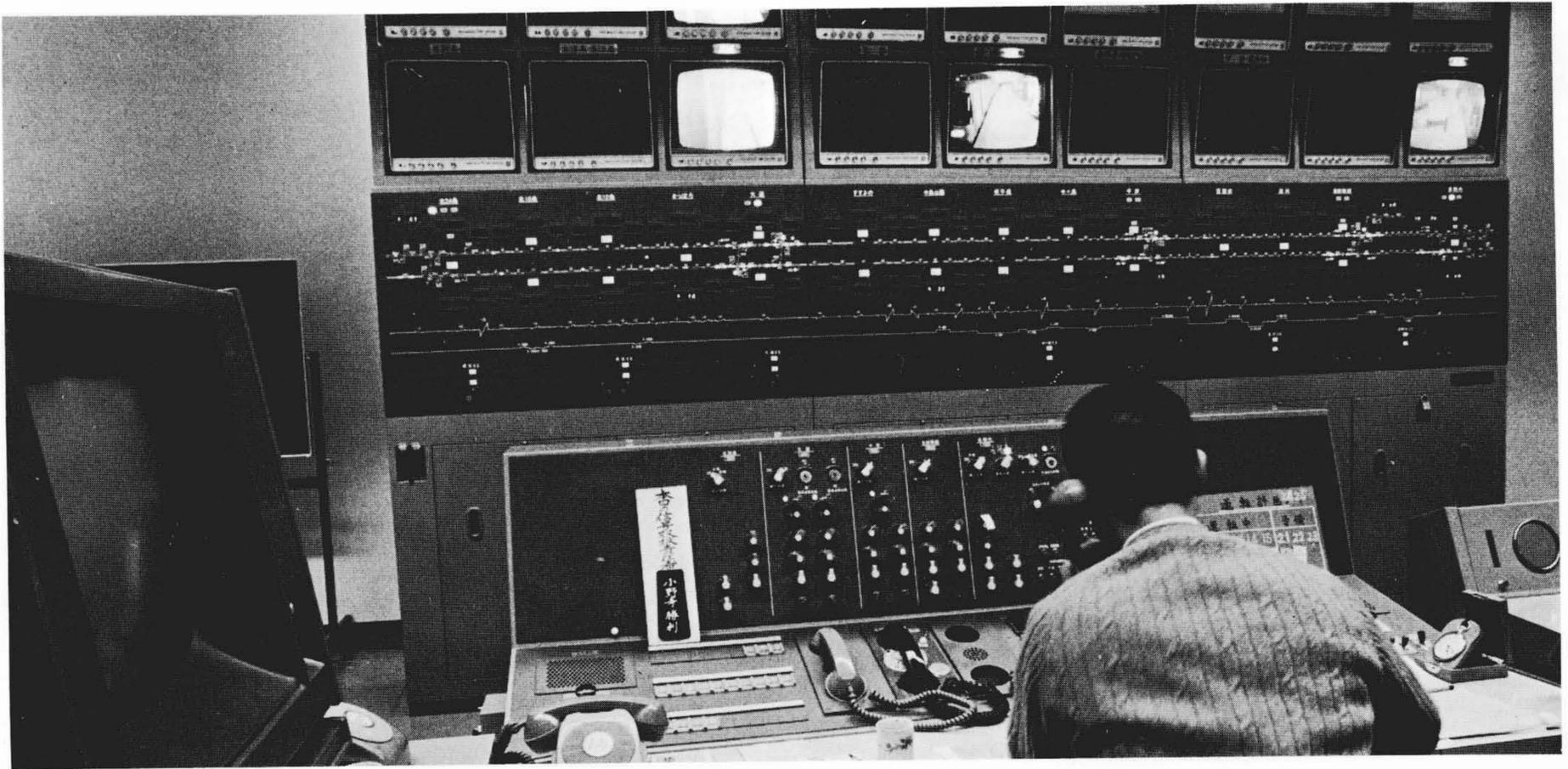
図3 運転指令室内の状況 運転指令室には、カラーディスプレイ、CTC表示盤などのほか各駅のホーム監視用テレビが設置されている。
