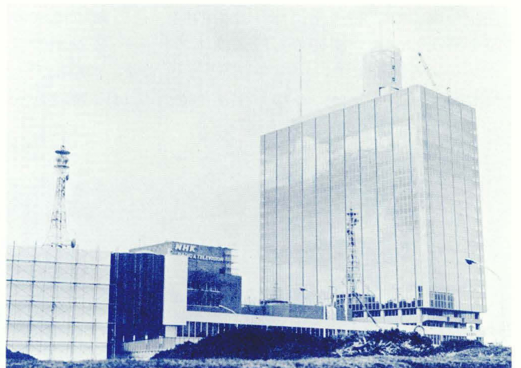
図1 NHK放送センタービル外観
