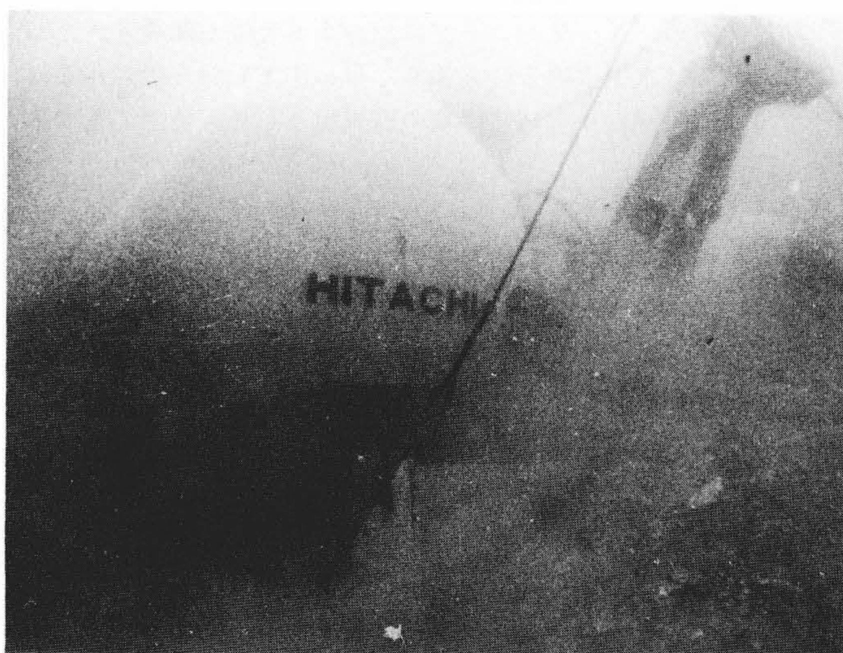
図9 海底で土砂を掘削する水中ブルドーザ
