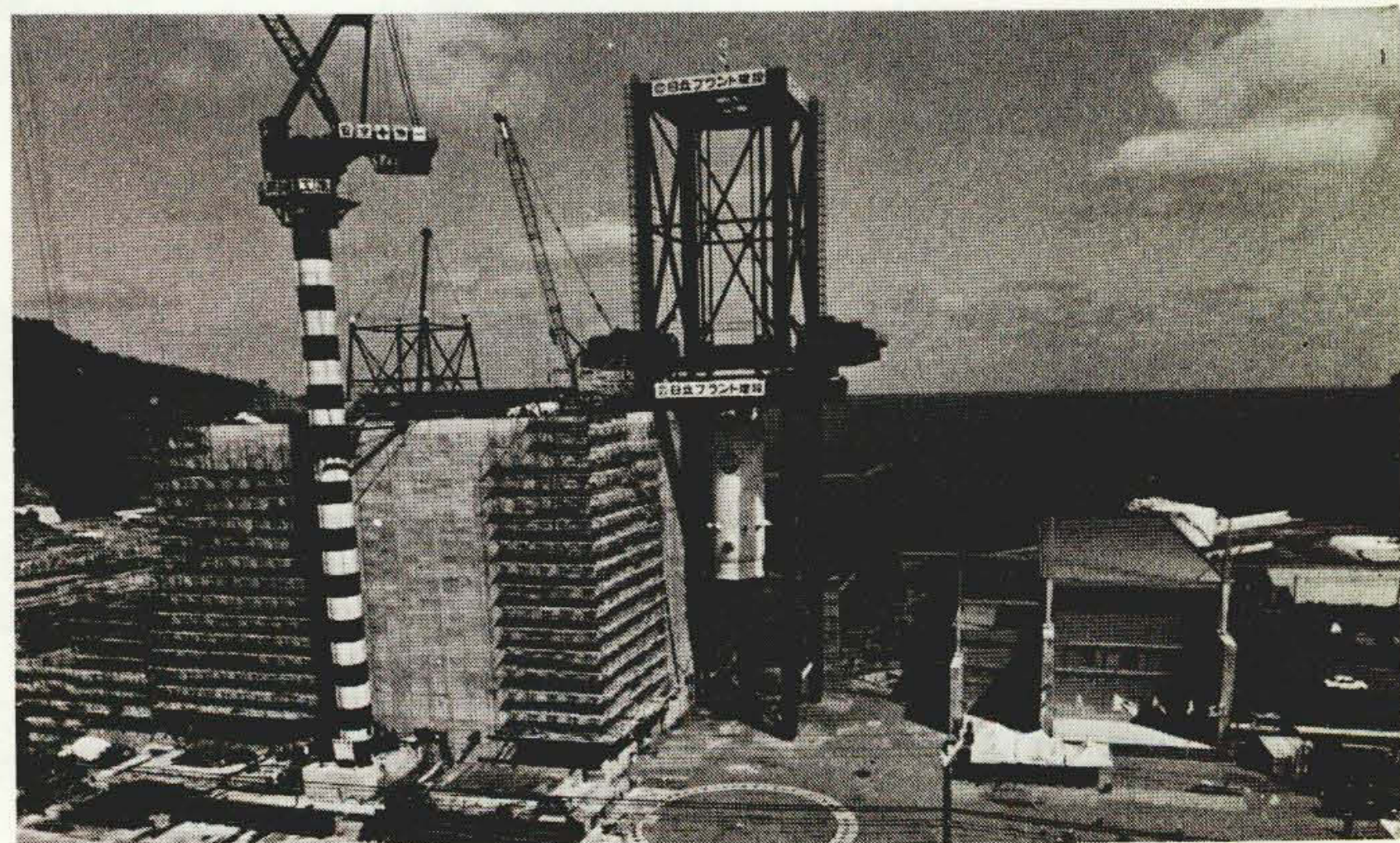
図1 建設中の中国電力株式会社・島根原子力発電所状況(昭和47年3月現在)
