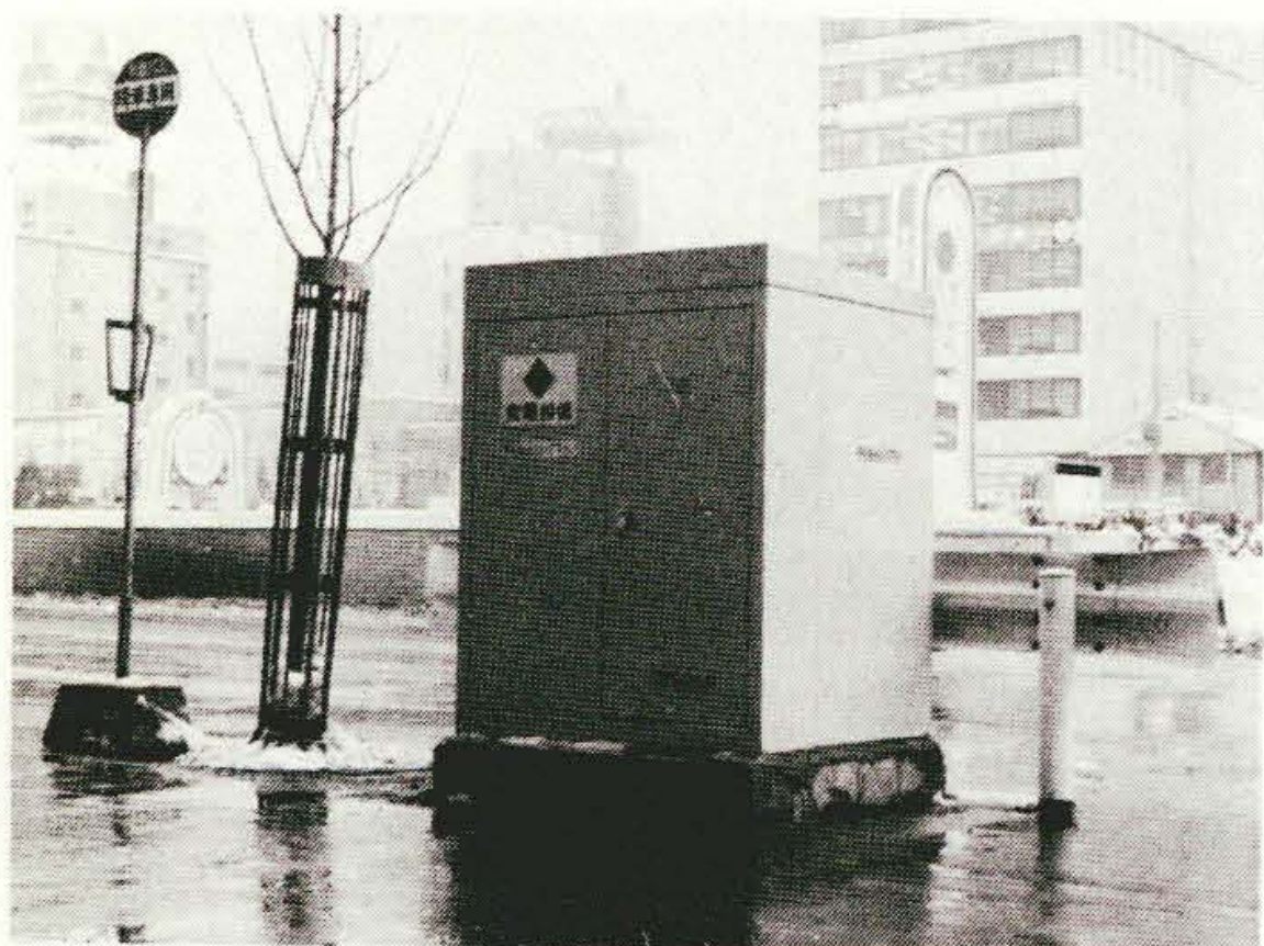
図28 札幌市納めロードヒーティング用パッドマウント変圧器
