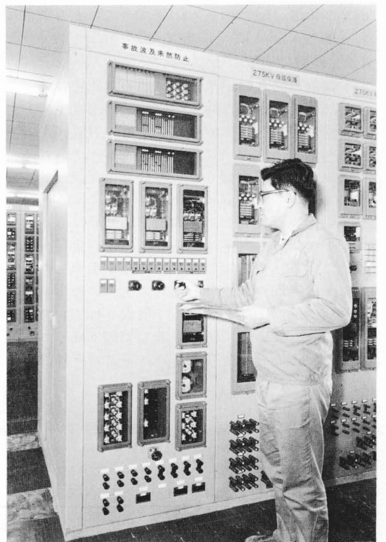
図6 事故波及未然防止装置 事故波及未然防止装置の外観を示したものである。
