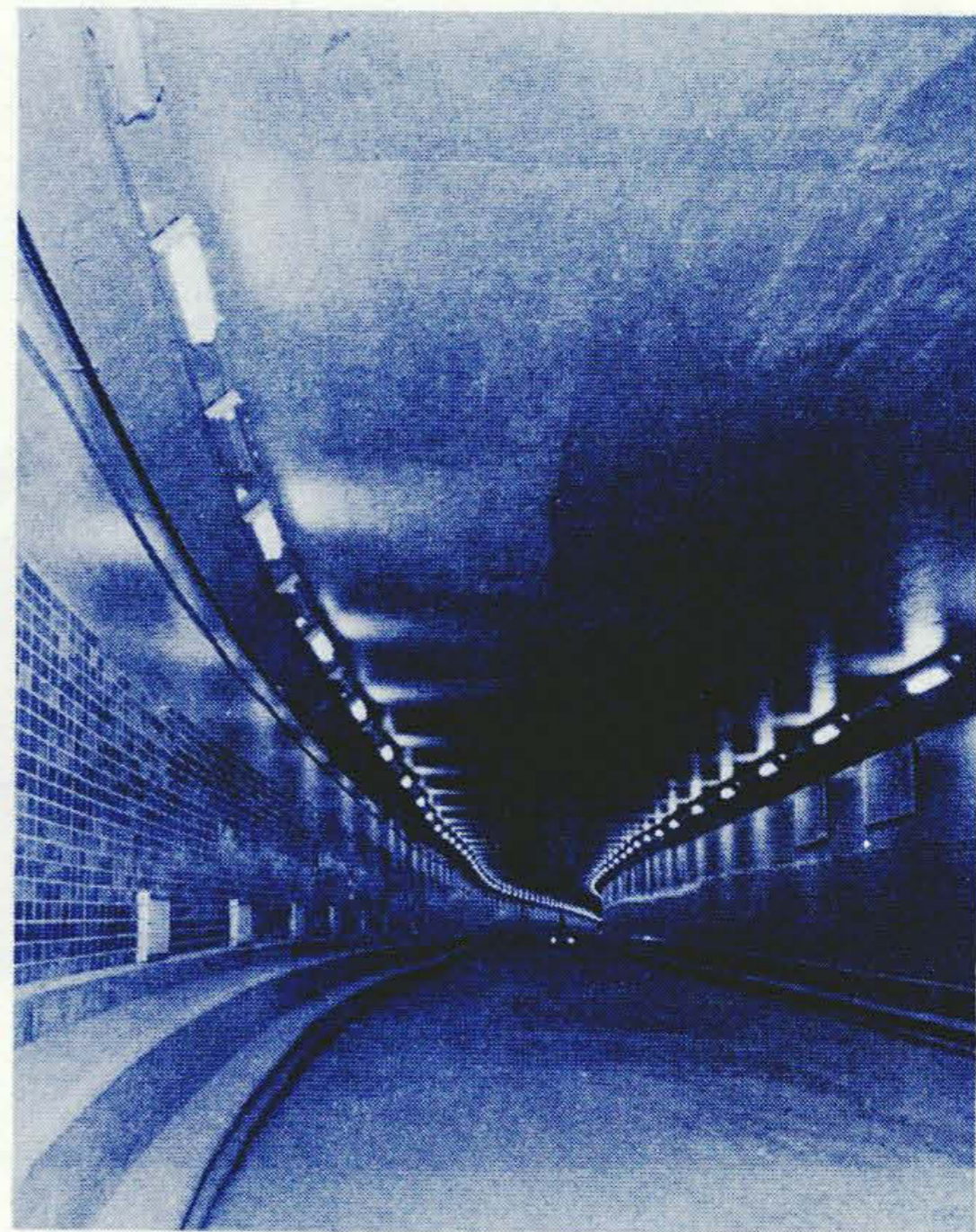
図13 八重洲トンネル内ケーブル架設状況
