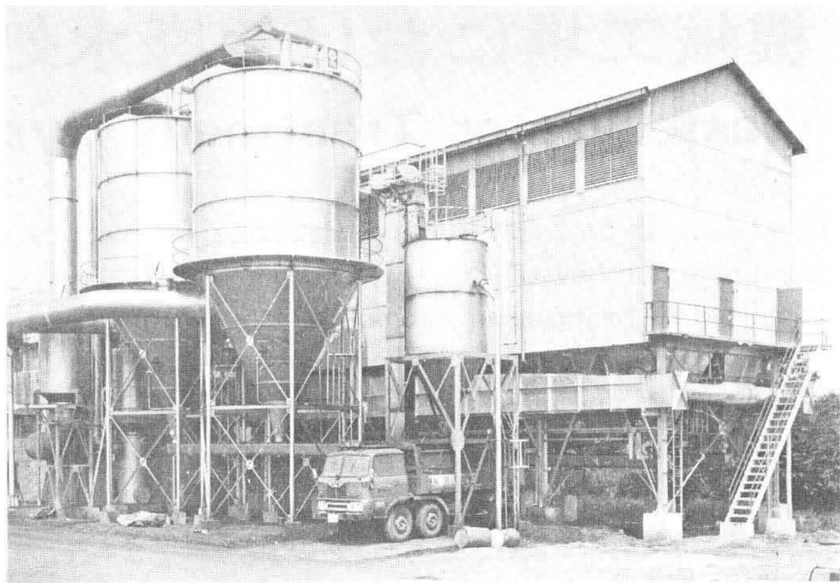
図11 集じん装置部分全景 直接集じん装置用密閉丸形バッグフィルタおよび建屋集じん装置用開放角形バッグフィルタを示す。
