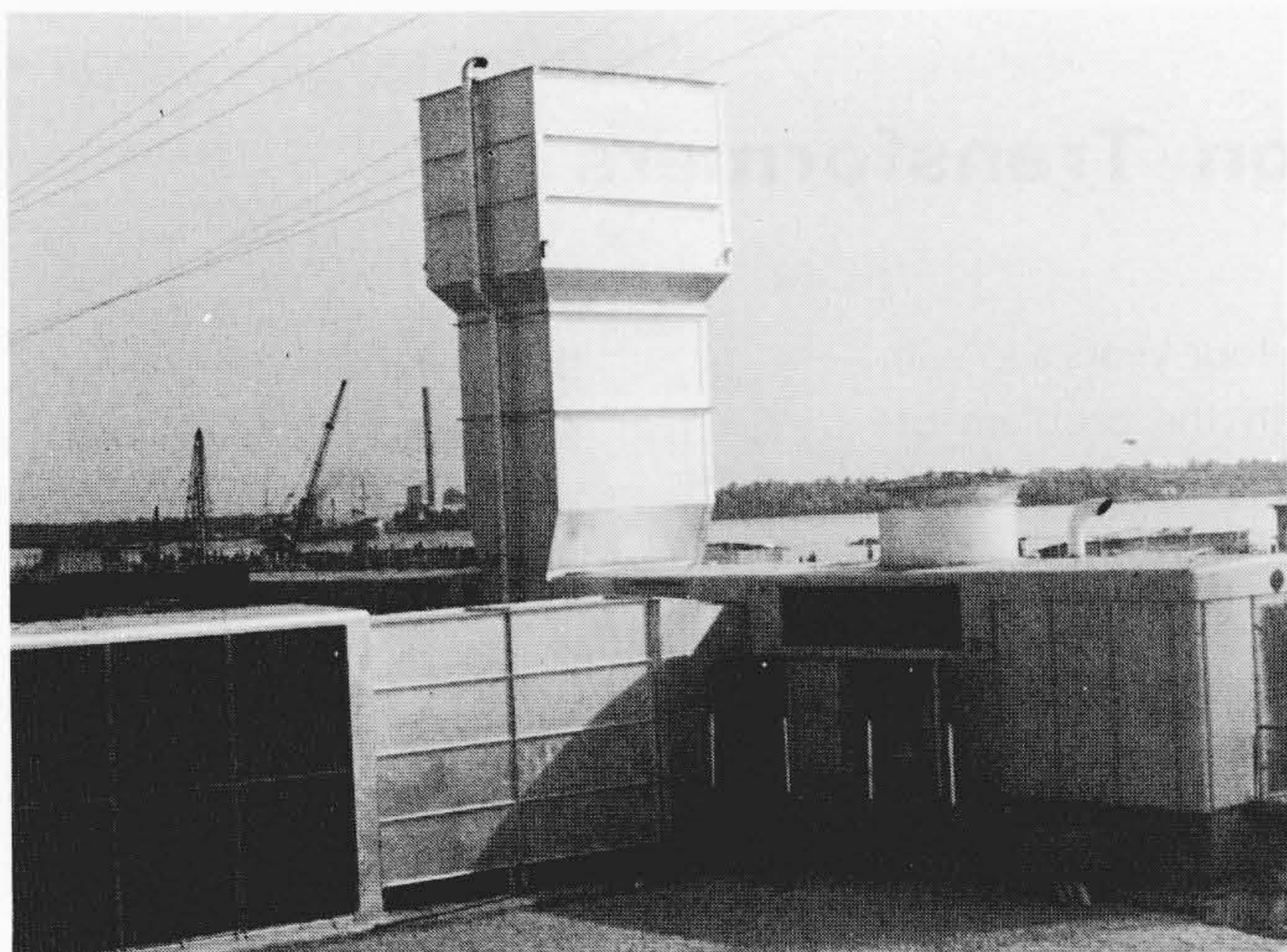
図16 18,000kW級ガスタービン外観 18,000kW級ガスタービンに標準のサイレンサを取り付けた外観を示す。
