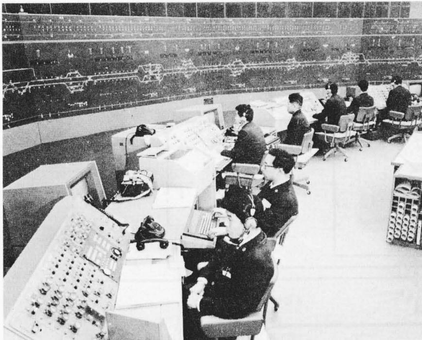
図1 制御用計算機により運行制御される新幹線中央指令室
