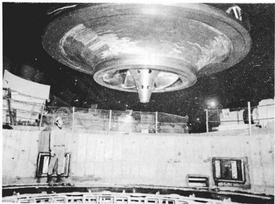
図2 230,000kWポンプ水車ランナ組込作業 高落差ポンプ水車のため、のみ口幅の狭い扁平ランナとなっている。
