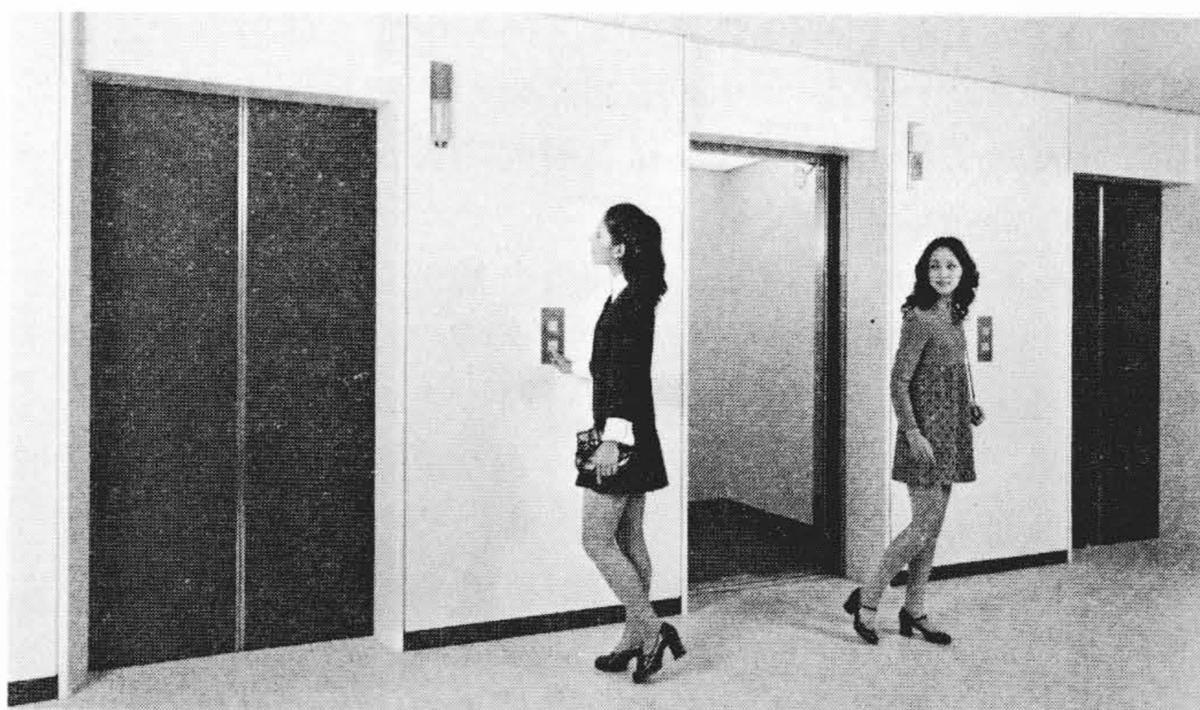
図3 NHK放送センター本館納めCIP/ICエレベータ ホール待ち客の待ち時間を短縮するとともに、サービス案内灯によりホール呼び登録時にサービスエレベータを表示するなど、エレベータの待ち客サービスが飛躍的に向上した。
