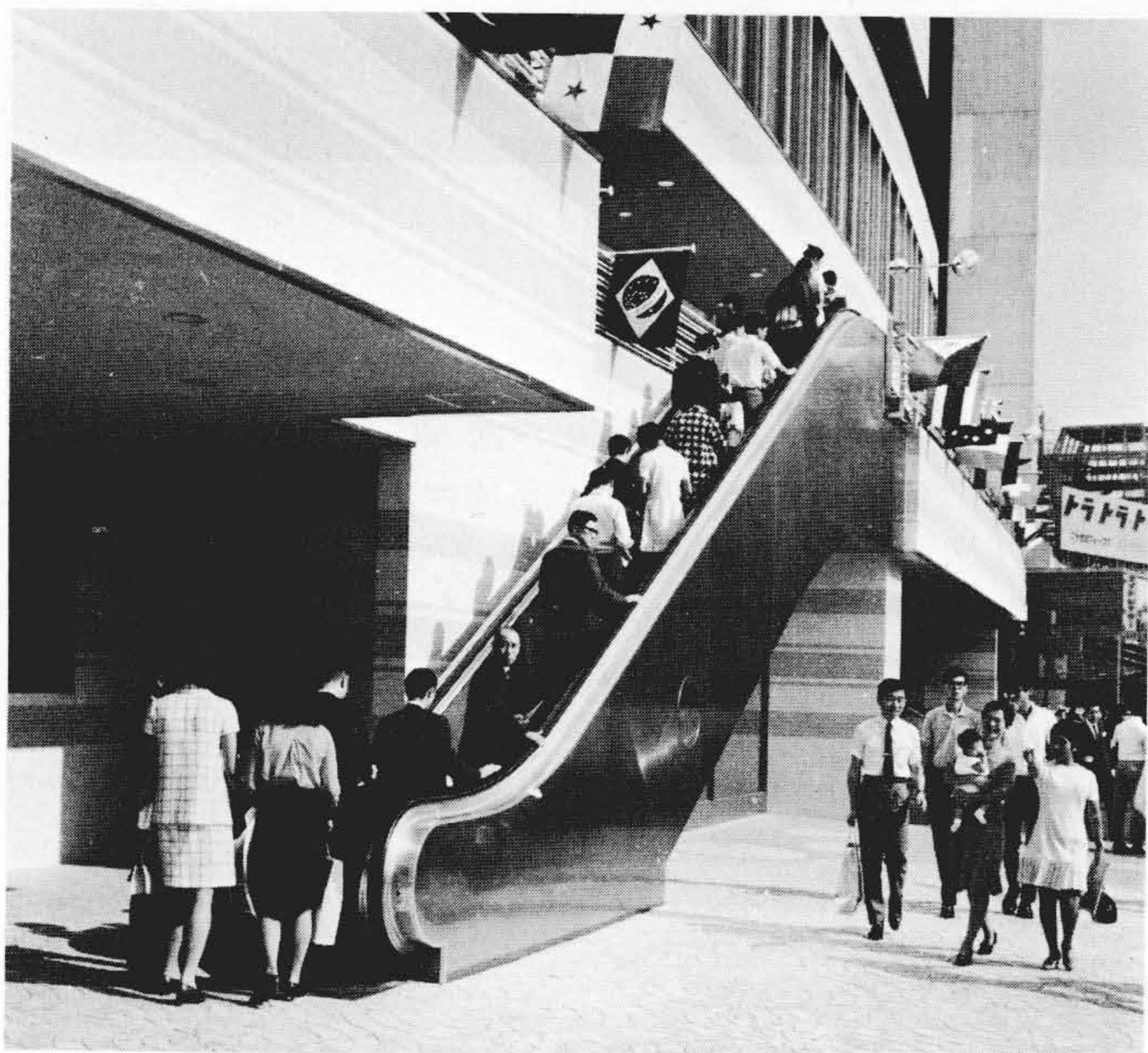
図1 日立屋外設置エスカレータ 赤坂・東急ビル納め800C-PA 日立屋外形エスカレータの稼動状況を示す。
