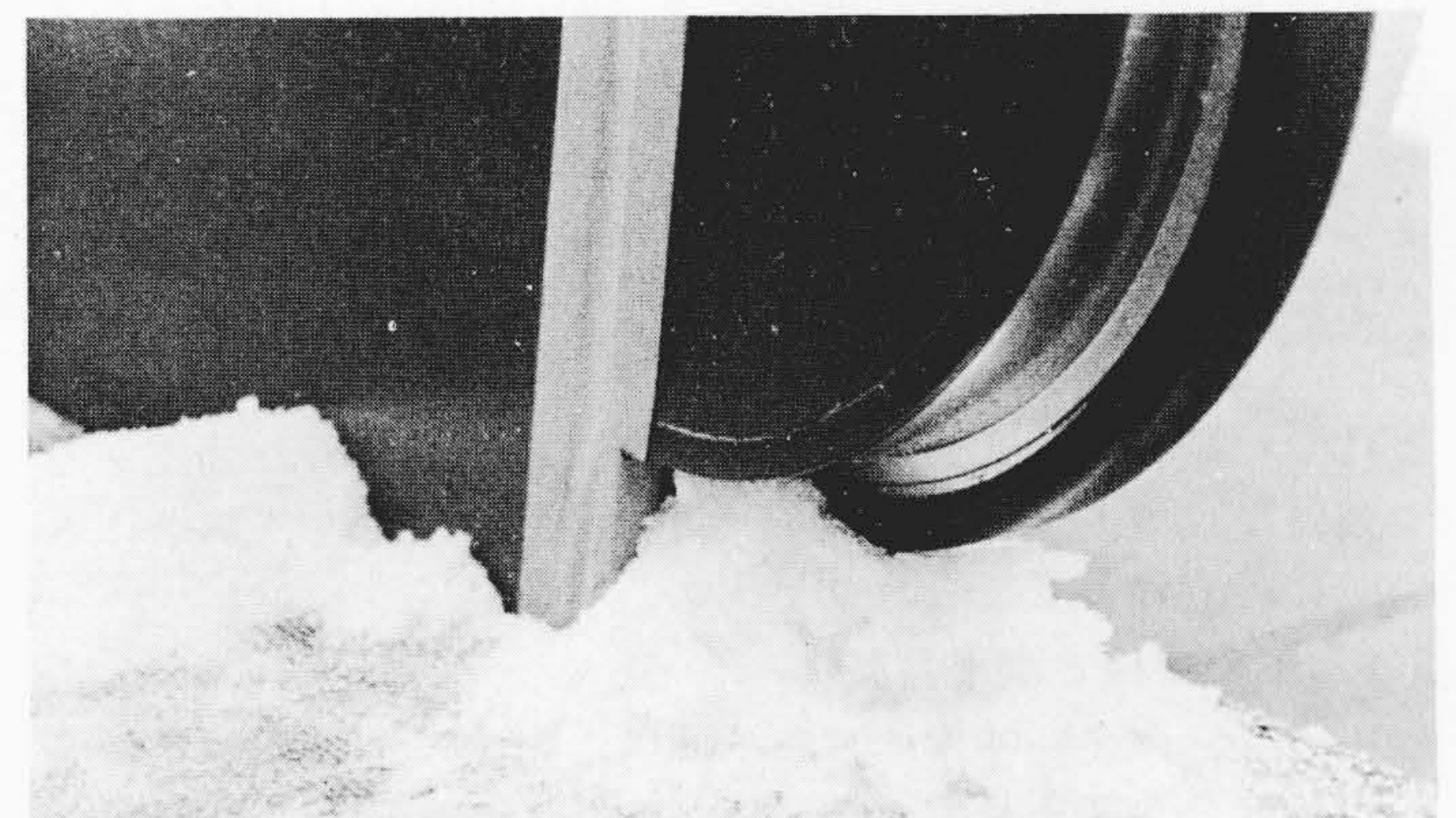
図4 積雪状態での運転例 踏み段およびハンドレール上の雪は、降り口に運ばれて山積み状態となる。
