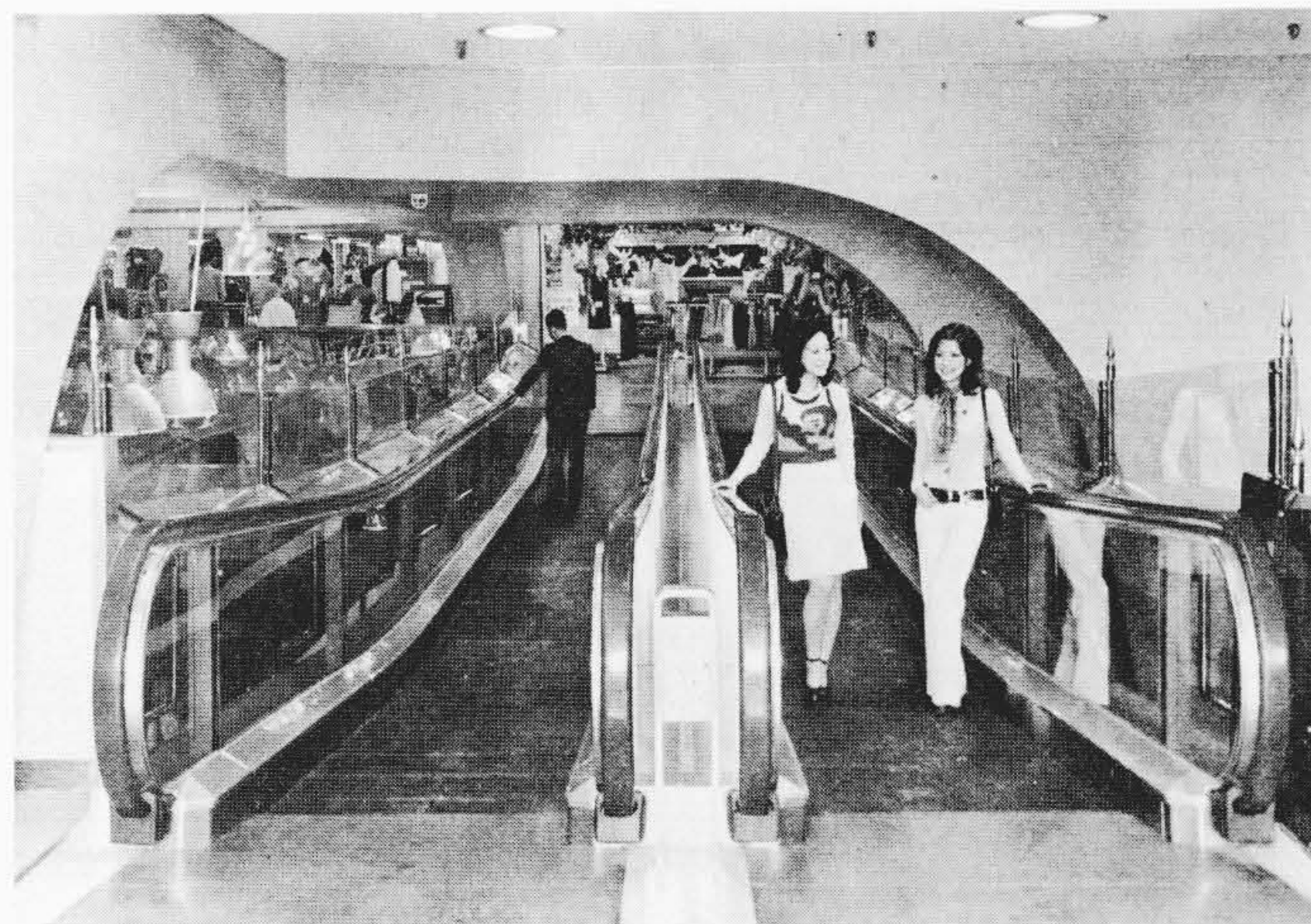
図7 百貨店への応用(東急百貨店日本橋店納め、日立1200CSG-NN形(全透明形)オートライン) 従来、隔離していた売場への連絡路としてオートラインを導入し、スムーズな顧客誘導を可能とした。
