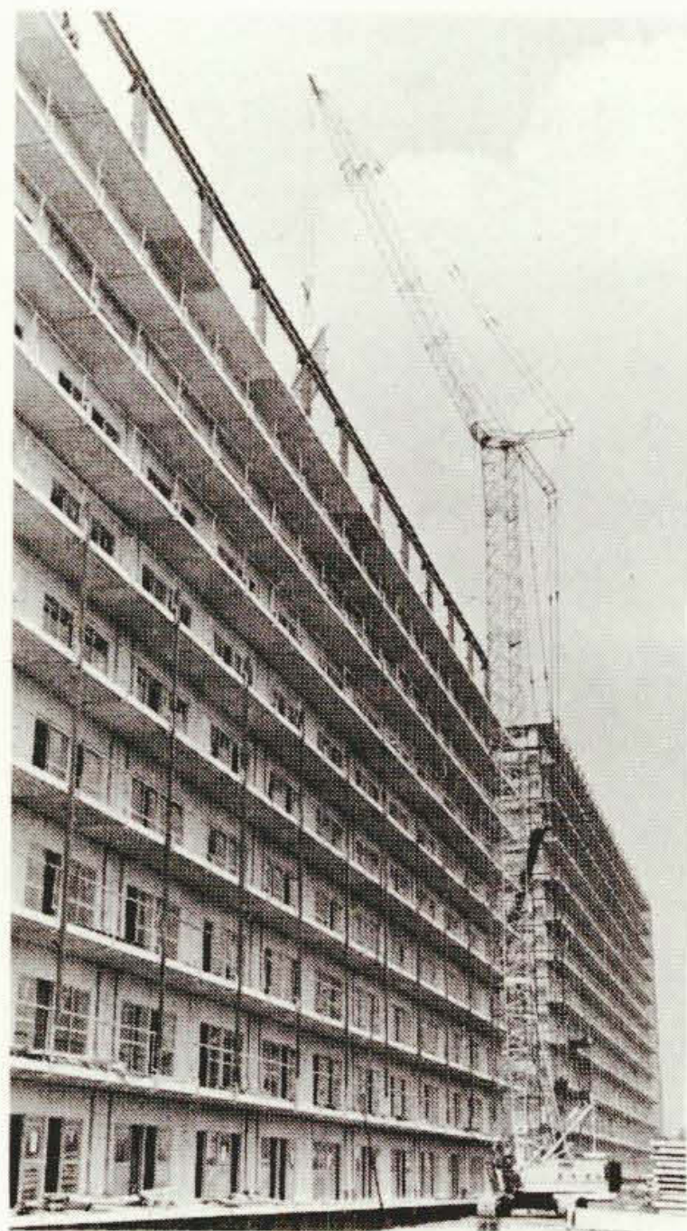
図41 KH150タワークレーン
