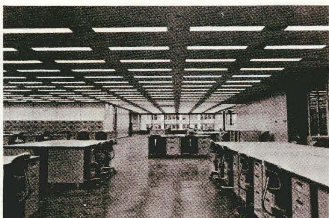
図32 サンワ東京ビル システム天井による 事務室の照明
