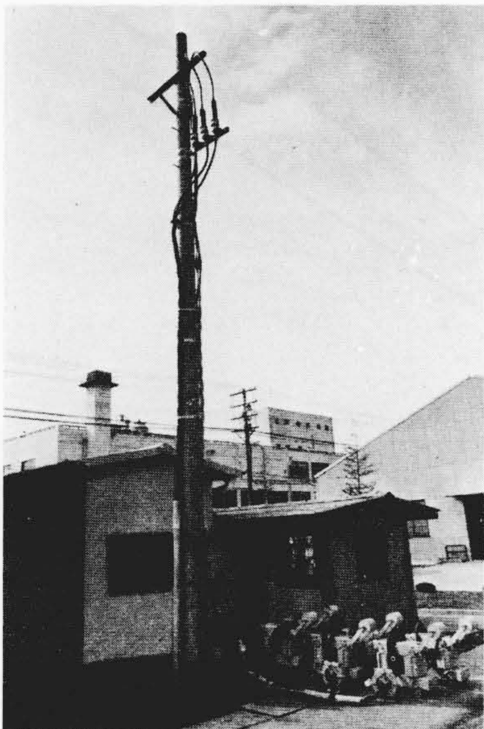
図4 アルミ導体CVケーブルの布設 装柱状況 軽量のため布設、装柱作業性は良好である。
