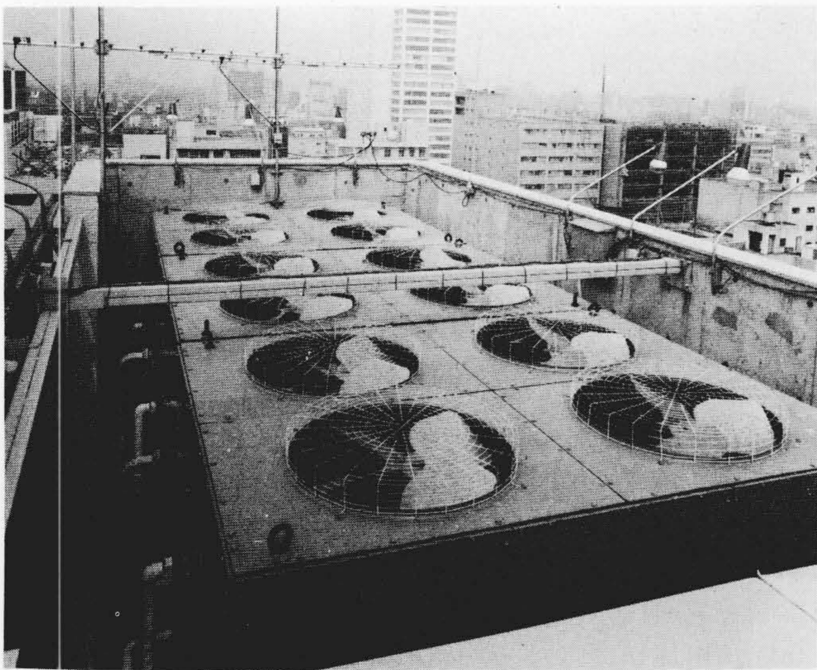
図7 空冷ヒートポンプ式チラーユニット設置状況 水側熱交換器ユニットは空気側熱交換器ユニットの下側に設置されている。
