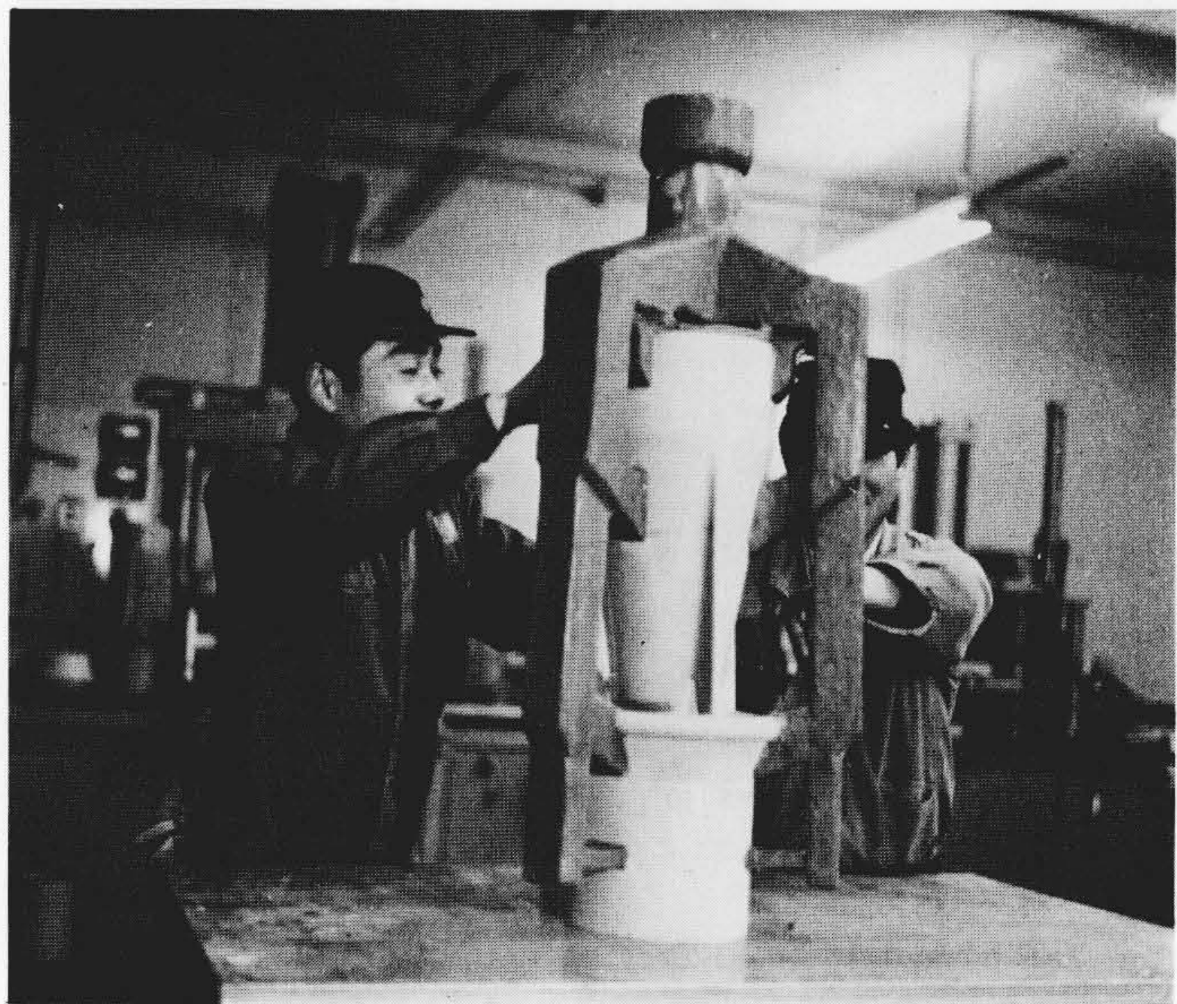
図5 完成したワックス模型 金型にて成形したワックス模型のほか、湯道もワックスにて作り、組み合わせて完成したものを示す。
