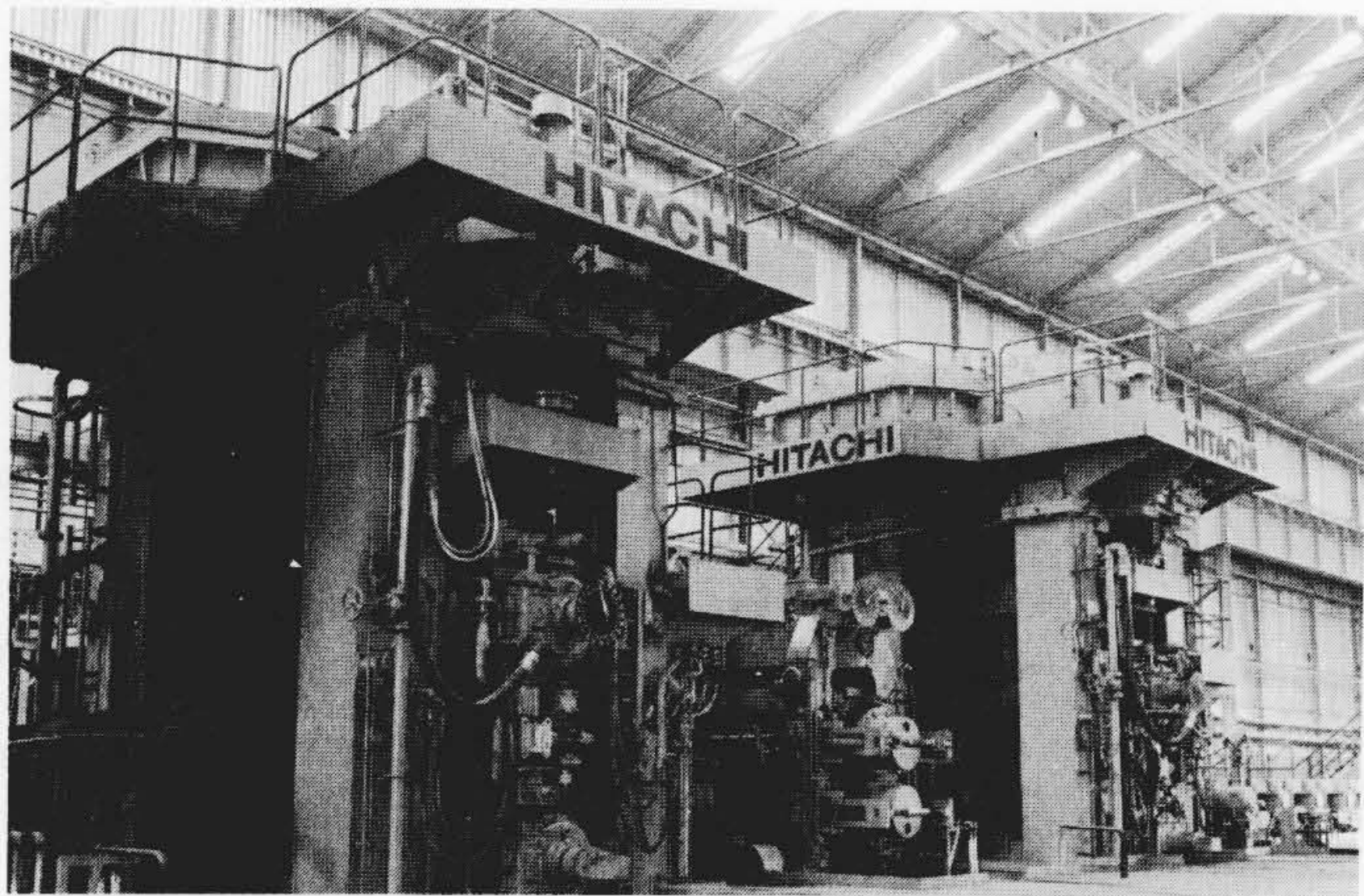
図2 連続ビレット ミル 稼動中のV-H 4 スタンド連続ビレットミルを示す。
