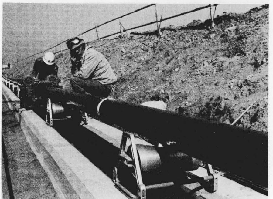
図8 ケーブル布設 ケーブル布設には、電動又は油圧式キャタピラ6台及び電動ローラ7台を分散配置して、同期駆動による完全な機械延長方式を採用した。
