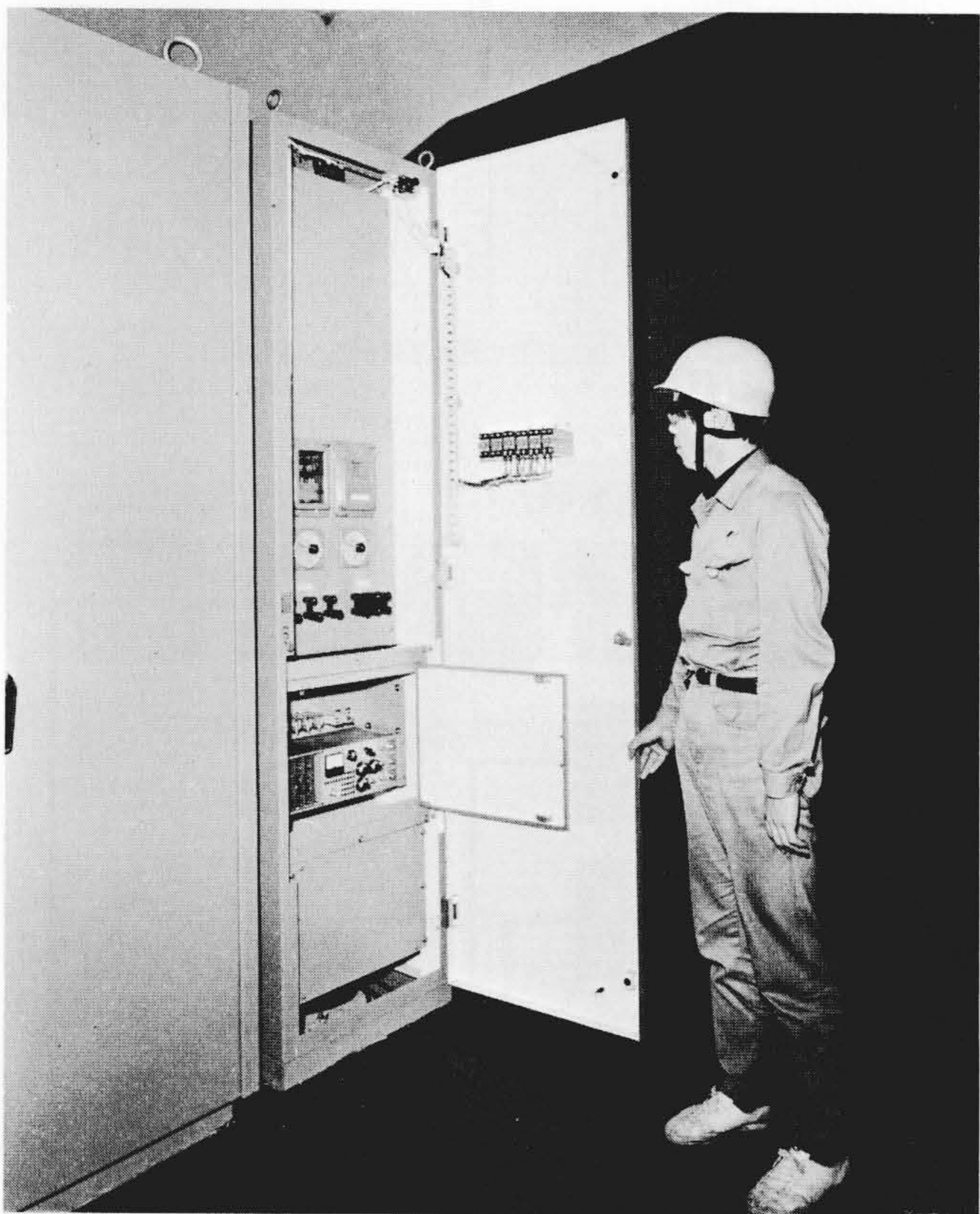
図7 PSSキュービクル PSSの制御ユニットはIC回路で構成され、ユニット用ボックスに収納されている。
