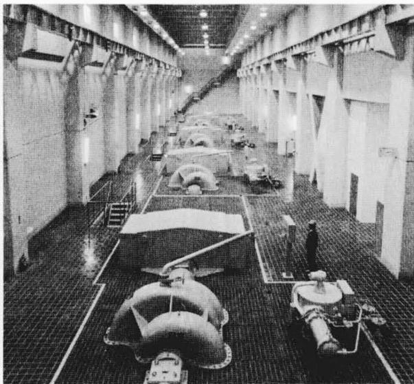
運転中の4,600kW 静止セルビウス制御方式誘導電動機
