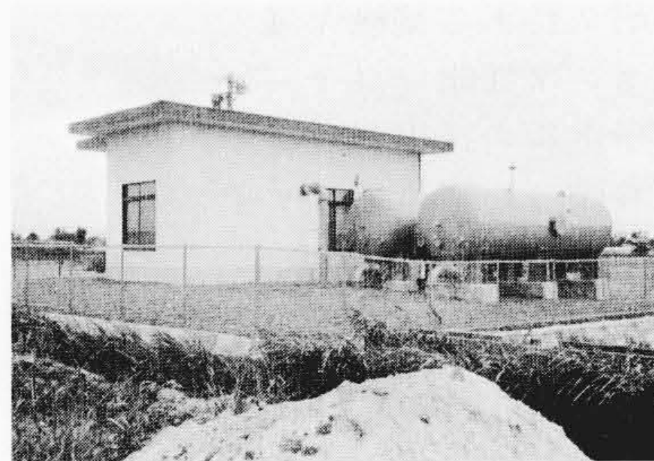
稲作灌漑用として使用した大水量「ウォーターエース」の現地据付状況
