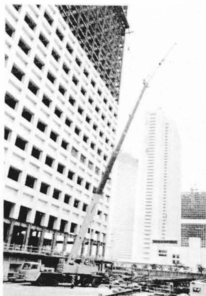
FH-100形伸縮ブーム式油圧トラック クレーン
