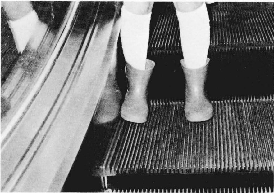
図1 デマケーションライン付ステップ ステップ3周辺に明るい色のデマケーションラインを取り付け、且つ側端の棧を高くして安全性を高めている。
