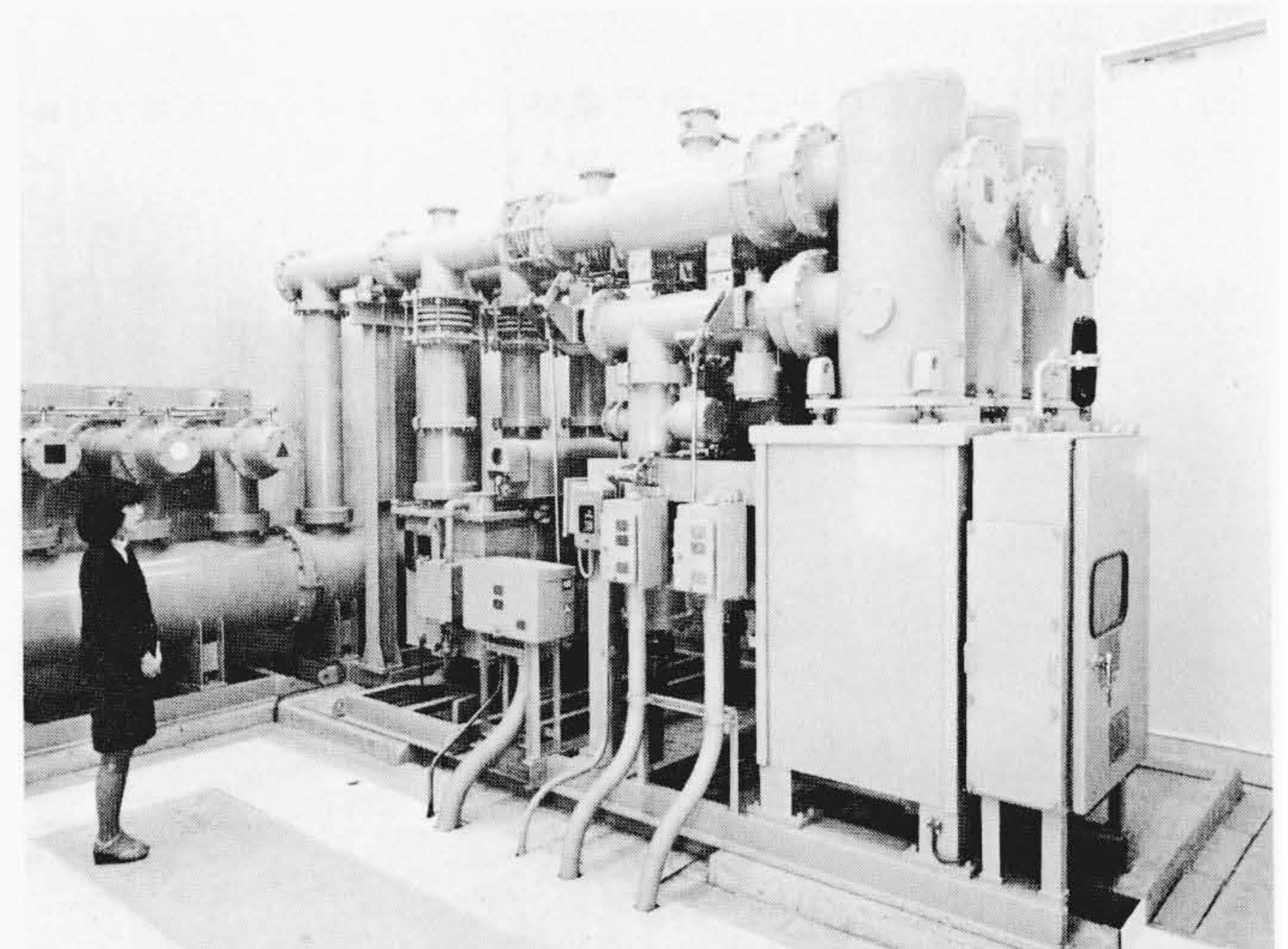
図6 SF 6 ガス絶縁開閉装置 特高受電部機器をSF 6 ガス絶縁母線で連結し、大幅にスペースが縮小されて信頼性、保安性ともに優れ、今後の特高変電所の主流とみられる。
