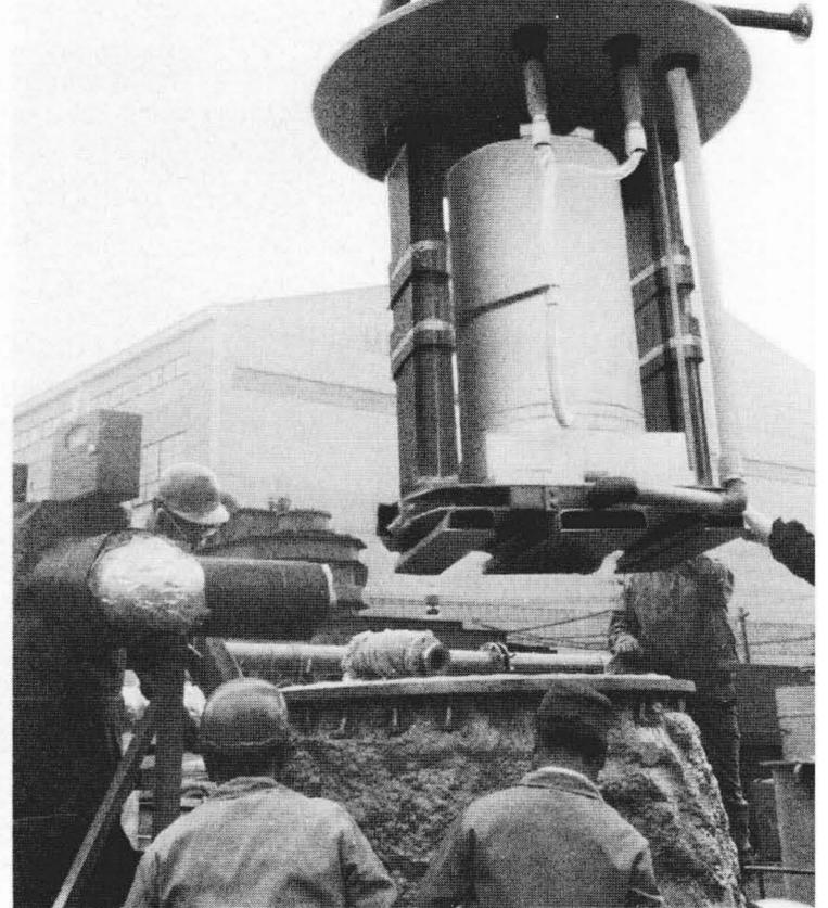
きたが、最近では直下形地震に対する安全性の再確認、軟弱地盤に建設する場合の設計計算法の確立などが研究課題になっている。現在このような状況に対処するため、(1)人工地震波の作成、(2)地盤の弾塑性を考慮した建屋との相互作用の究明、(3)大地震に対する原子炉炉内構造物の実機及びモデルの耐震試験並びに解析手法の確立などを行ない、耐震解析法全体の精密化を図っている。
