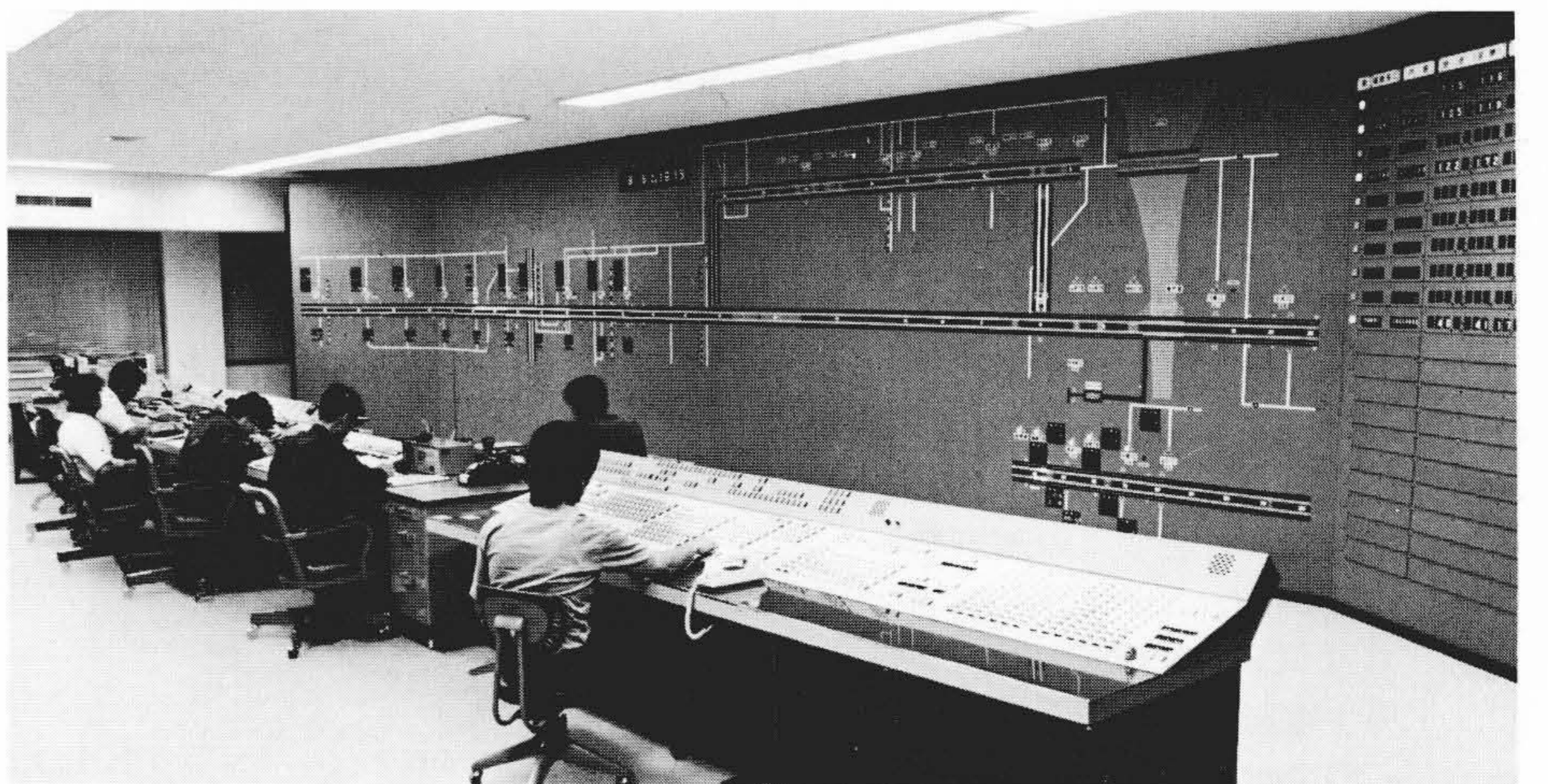
図18 日本道路公団福岡管理局制御システム
