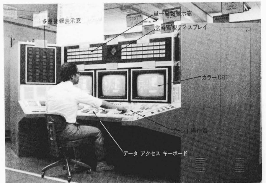
図9 運転員コンソール カラーCRT、多重警報表示窓、ページ式操作スイッチなどの採用により、従来の制御盤の約1/10に小形化し、ワンマンコントロールを可能にした。
