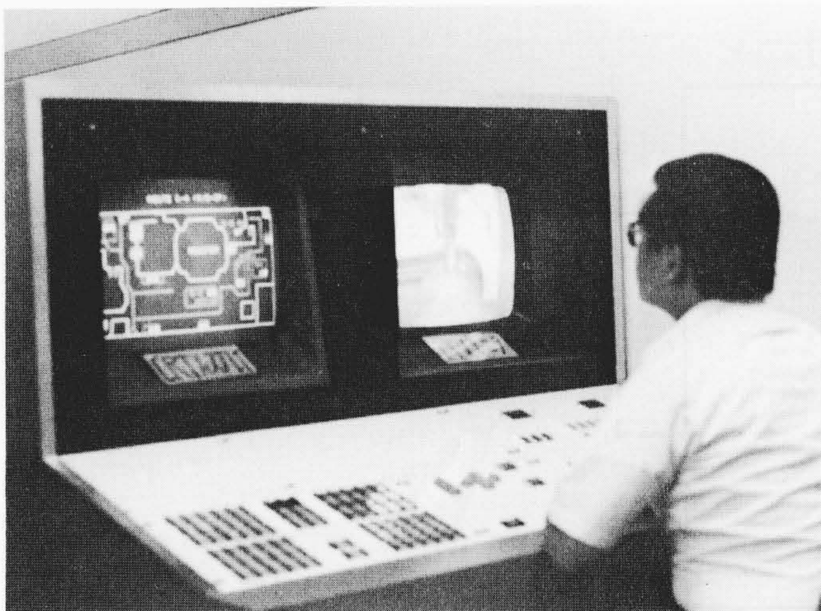
図3 移動式点検装置のコンソール 中央操作室に設置する。上部左はCRTディスプレイ、上部右はテレビモニタを示す。
